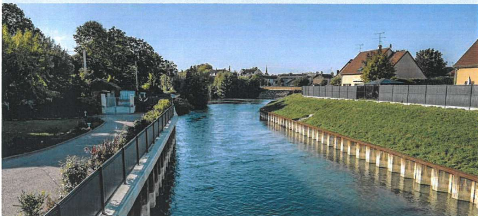
Digue de Fouchy, le long de l'impasse des Dames-Colle à Troyes
