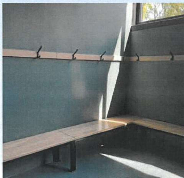
Les vestiaires du gymnase de Bouilly
