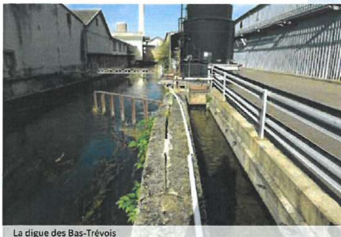
La digue des Bas-Trévois
