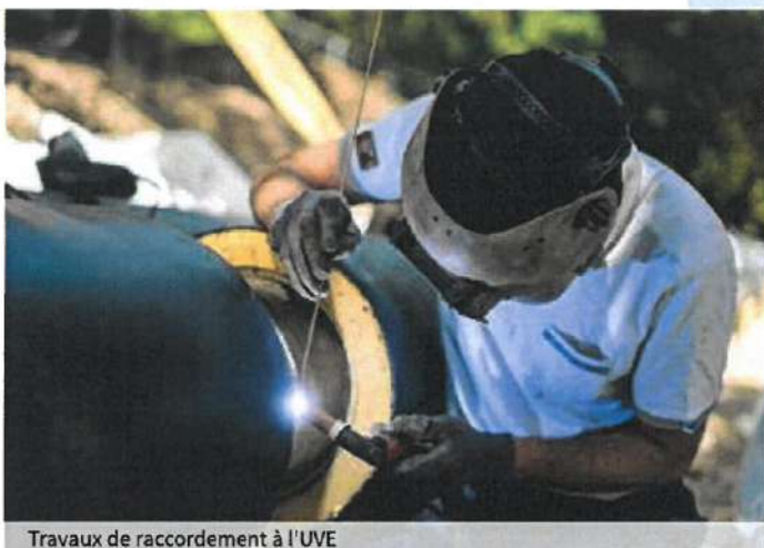
Travaux de raccordement à l'UVE
